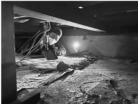
△ 床下の作業は大変
